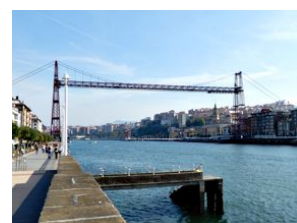
Bilbao Ponte di Biskaia
